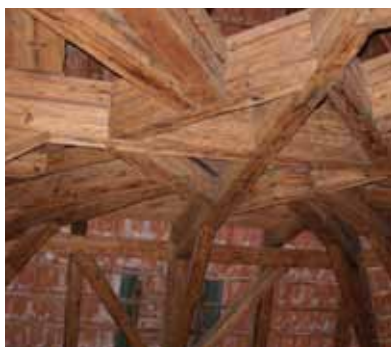
Masivní dřevěná konstrukce spodní části krovu Černé věže na Pražském hradě.
