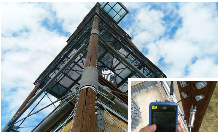
Kontrola rozhledny s dřevěnými prvky
