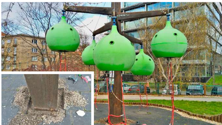
Kontrola dřevěné konstrukce herního prvku
