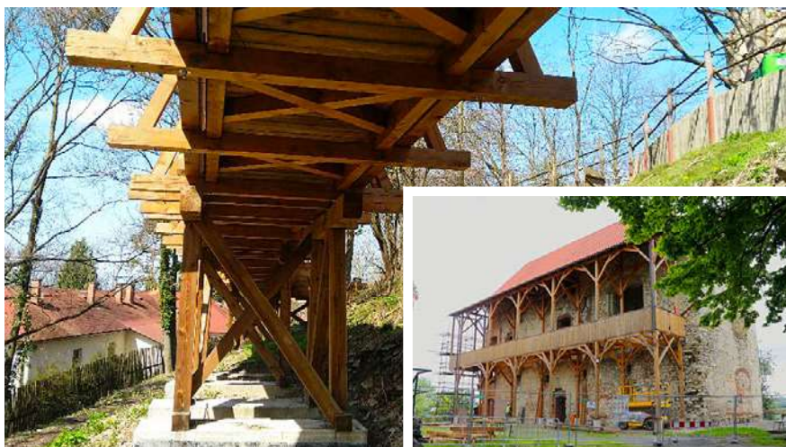
Kontrola dřevěných konstrukcí hradu
