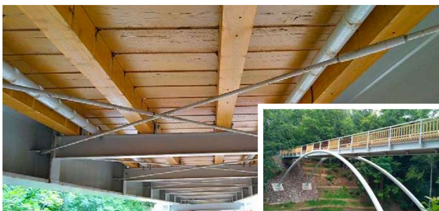
Kontrola dřevěné lávky pro pěší přes rokli
